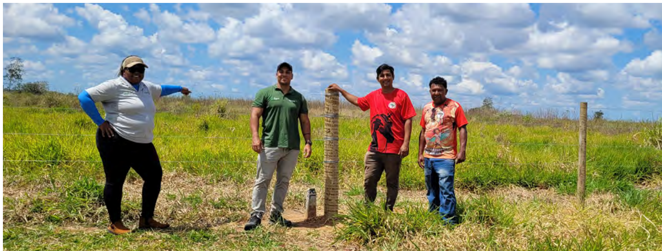
Foto 8. Construção de cerca para delimitar a área de plantio no Projeto Fábio Santos.
